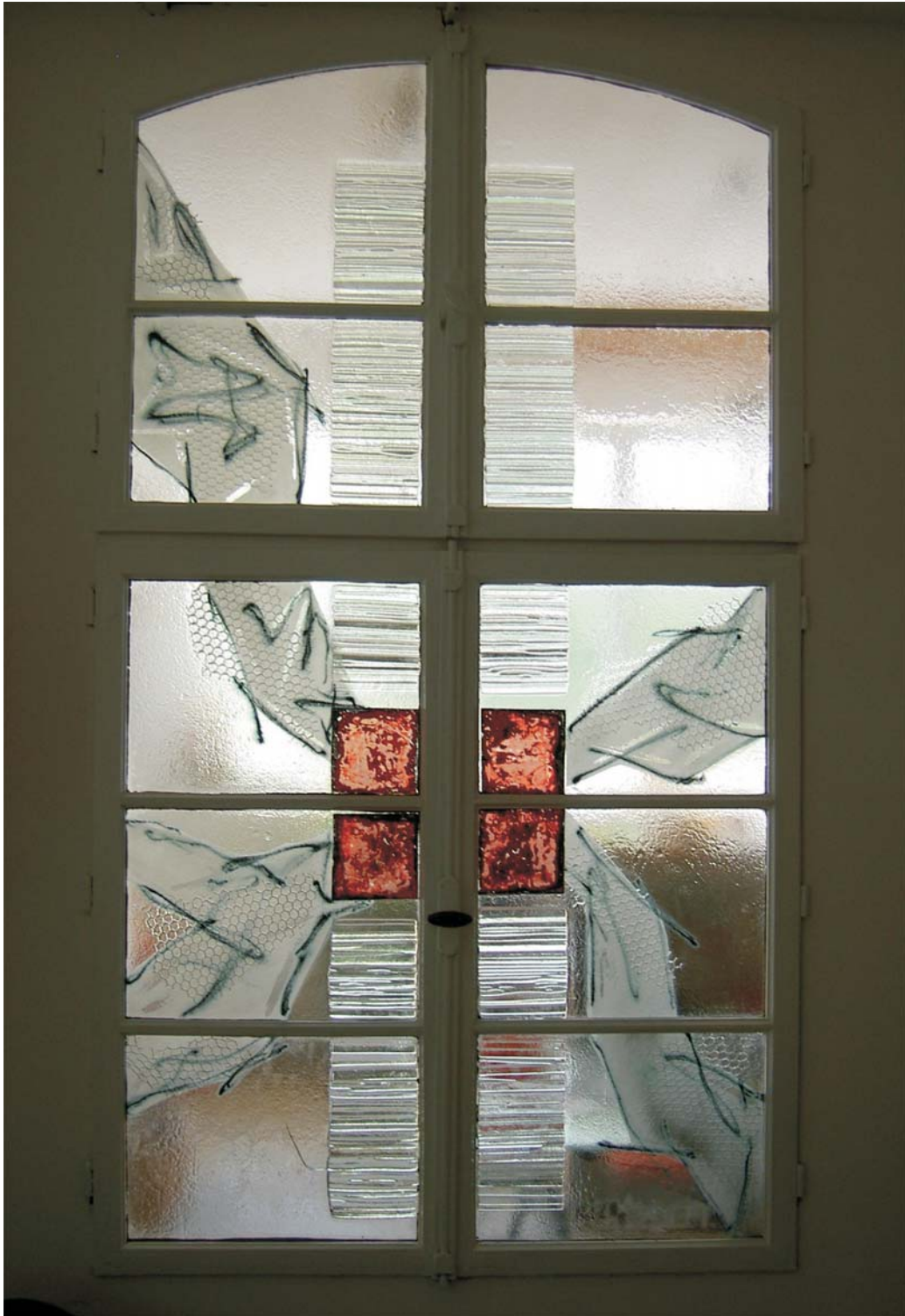
“Fenster” Raumabtrennung aus alten Fenstern mit neuem Glas
